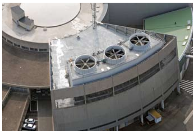
Les trois tours de refroidissement sur le toit de la CTFE
