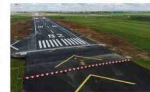
Réhabilitations de pistes
