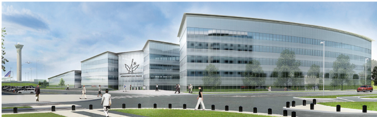
A view of the entire Aéroports de Paris head office at Paris-Charles de Gaulle Airport ©Aéroports de Paris
