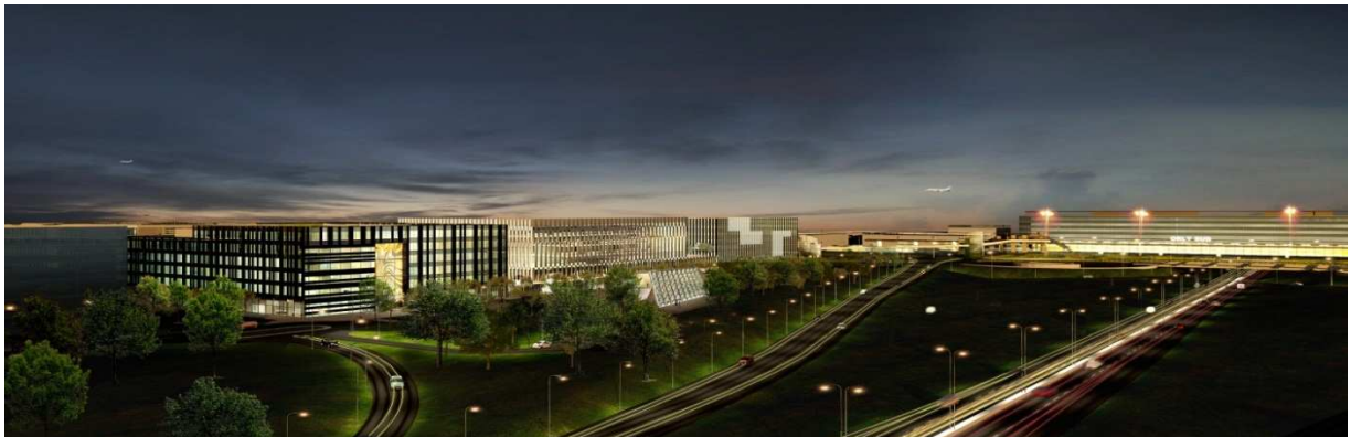
Vue globale de la première tranche de Cœur d'Orly avec l'immeuble Askia au premier plan ©ArteFactoryLab
