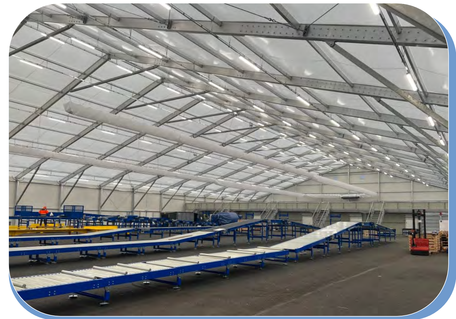
Structures temporaires dédiées pour le traitement des bagages enregistrés à l'avance ou à distance
