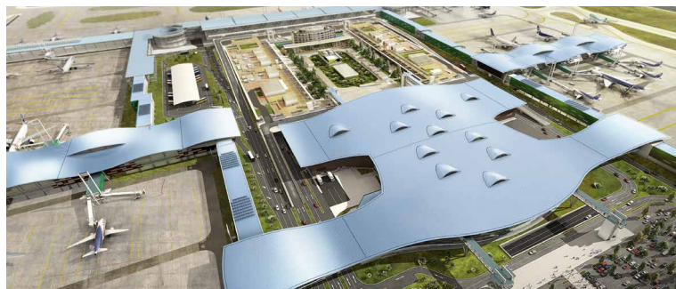
New terminal at Arturo Merino Benítez Airport - Santiago de Chile ©Nuevo Pudahuel
