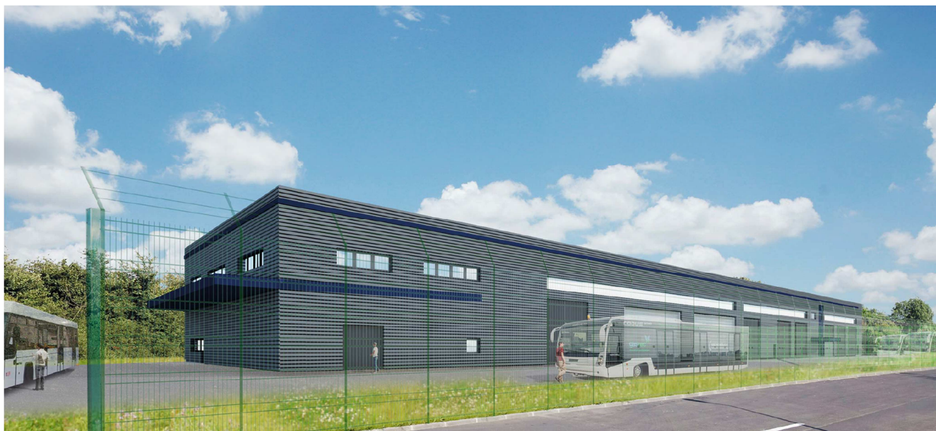
Centre de Maintenance Engins (CME) sur l'aéroport Paris-Charles de Gaulle © SAGL
