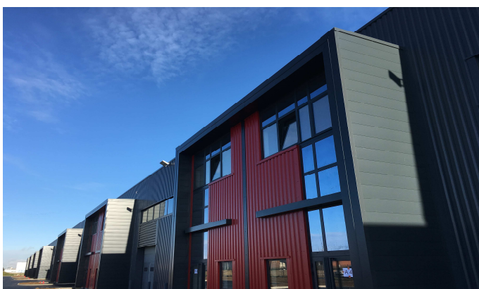
Vue Est du parc d'activités Roméo situé en zone Cargo de l'aéroport Paris-Orly ©Groupe ADP
