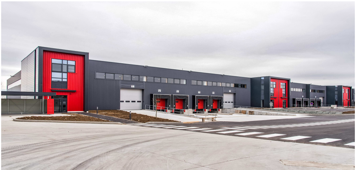
Vue du parc d'activités Roméo en zone Cargo de l'aéroport Paris-Orly ©BNP Paribas Real Estate
