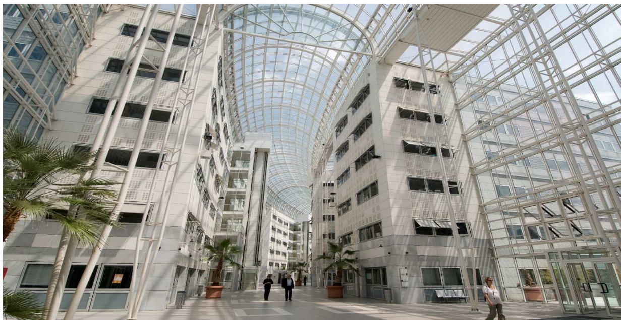
Vue Est du Dôme dans le quartier d'affaires Roissypole sur l'aéroport Paris-Charles de Gaulle ©Groupe ADP
