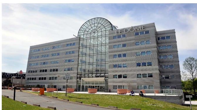
Vue Ouest du Dôme dans le quartier d'affaires Roissypole sur l'aéroport Paris-Charles de Gaulle ©Groupe ADP
